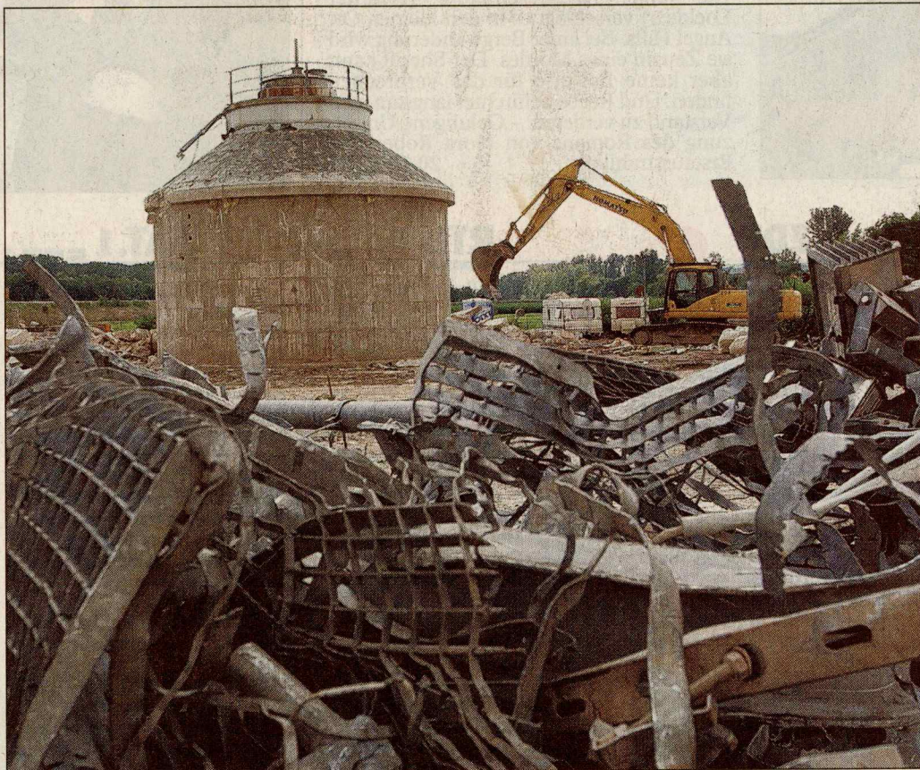
Von der alten Bodenheimer Kläranlage, direkt an der B9 gelegen, ist nicht mehr viel übrig geblieben. Auch Faulturm und Klärbecken werden demnächst abgerissen. Foto: hzb/Stefan Sämmner
